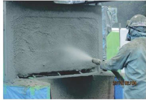
吹付施工の状況
