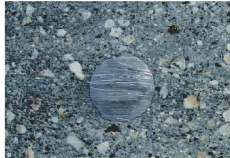
吹付施工硬化体鉄筋周囲の状況
