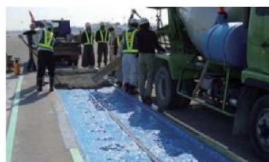
空港用薄層附着オーバーレイ工法 県営名古屋空港(2009年)
