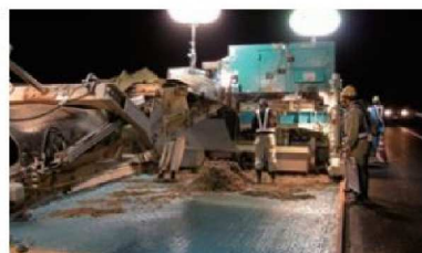
接着接合型コンクリート床版上面増厚工法 東北自動車道笹原川橋(2007年)
