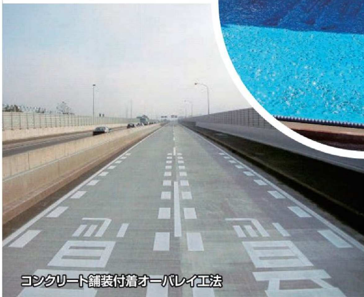
接着接合型コンクリート 床版上面増厚工法
