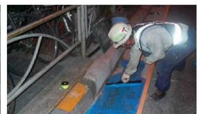
超速硬コンクリート街路嵩上げ工法 国道254号線 春日一丁目(2006年)
